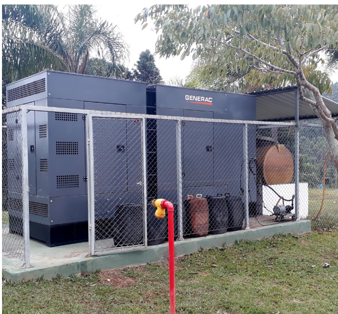
Grupo gerador Generac SWY400
