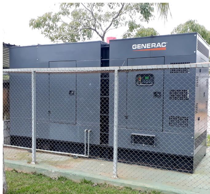
Grupo gerador Generac SWY400
